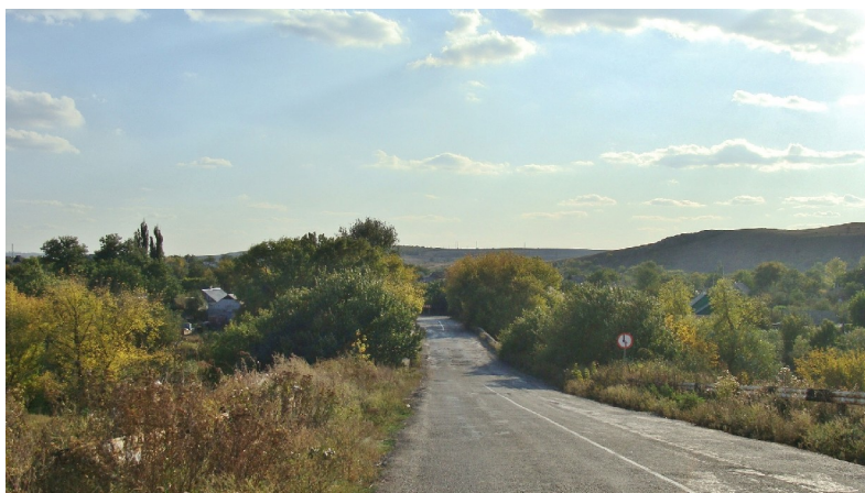
Abbildung 41: Panoramio Bild der nördlichen Brücke von Blahodatne; Die Aufnahme entstand von einer nördlich der Brücke gelegenen Position in Richtung Süden schauend; Quelle: http://static.panoramio.com/photos/original/109711580.jpg
